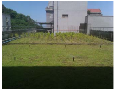
圖 6.2 屋頂隔熱系統
